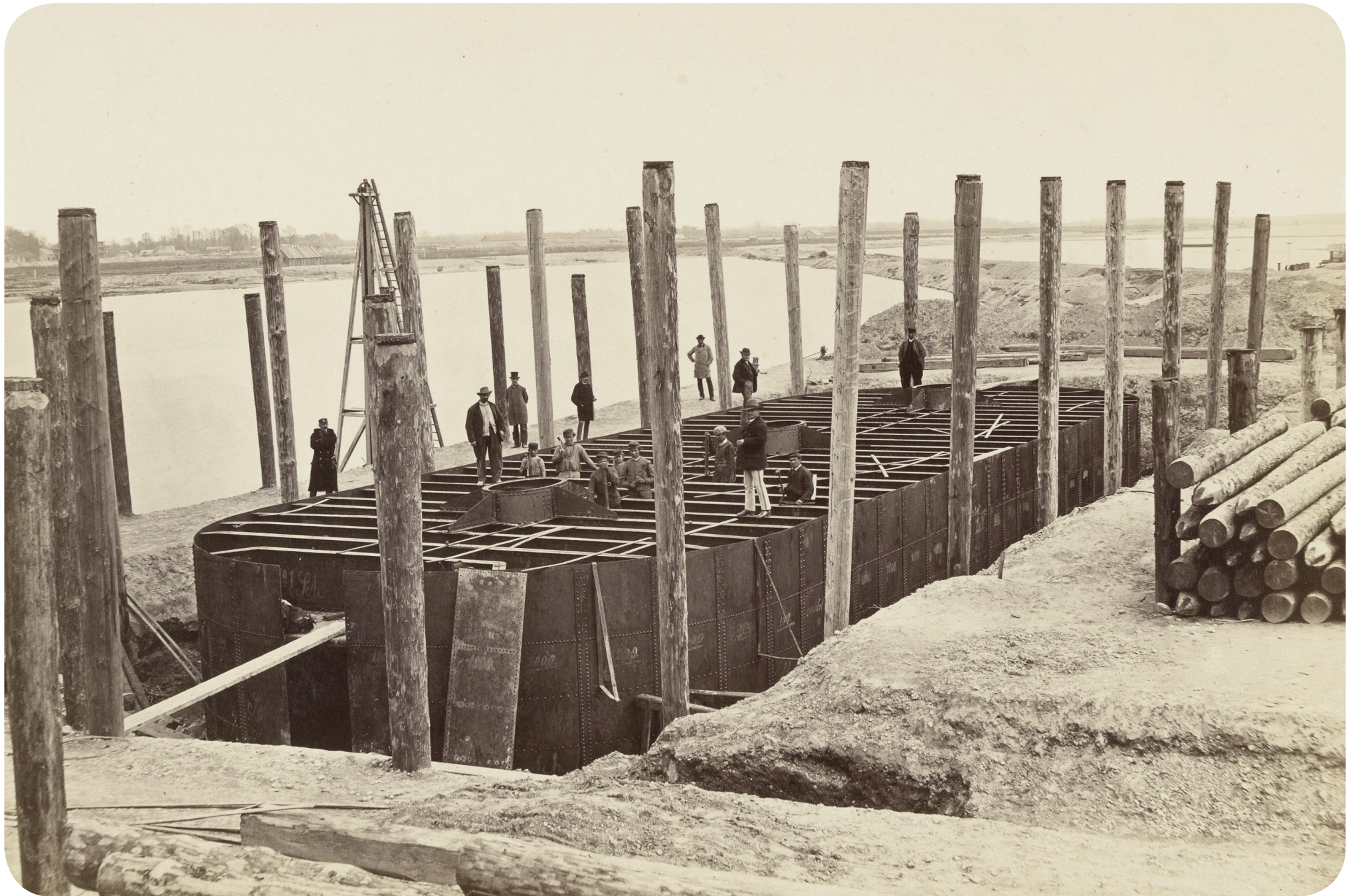
Hermann Heid / „Reichsstrassen-Brückenbau über die Donau“ / April 1873 / Wien Museum
