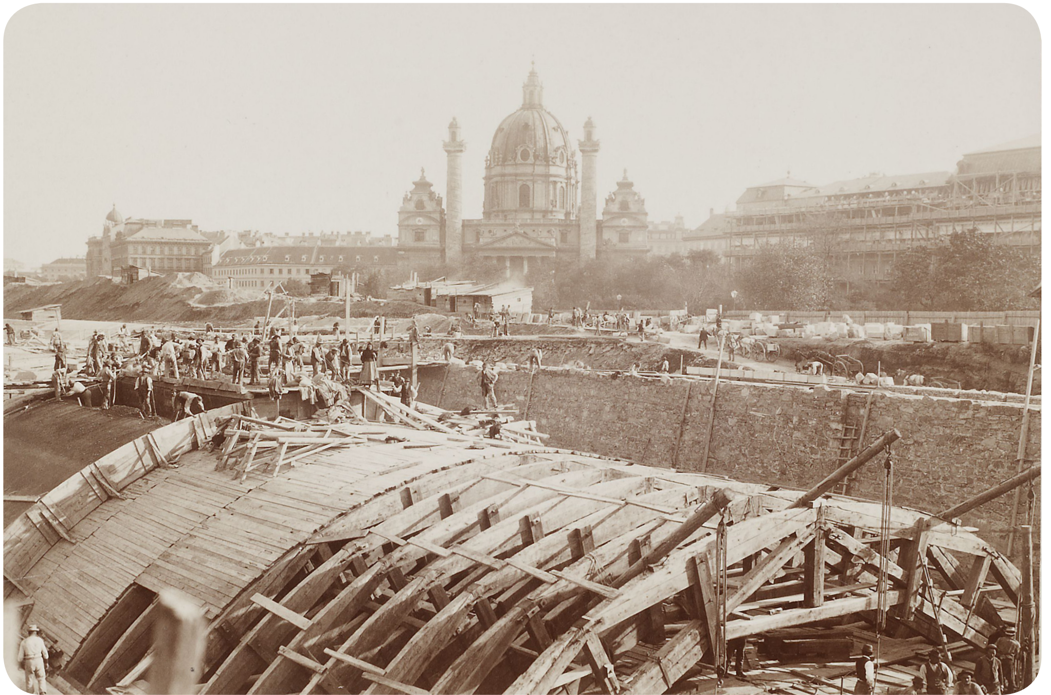
„Wienflussregulierung: Betonierung eines Gewölberings unterhalb der Elisabethbrücke“ / 11. Oktober 1898 / Wien Museum
