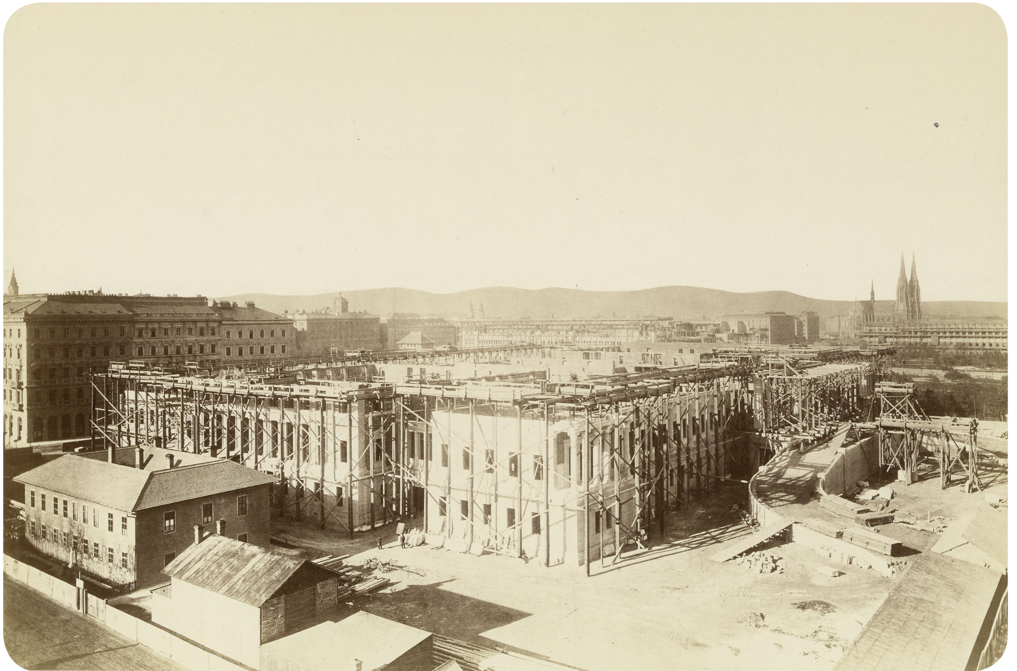
1., Parlamentsring - Baustelle des Parlaments / November 1877 / Wien Museum
